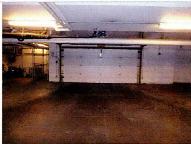
Parkade overhead door
